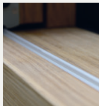
LAUSCHIENE Lautloses Rollen der Integralschiebetür auf der im Holz eingelassenen Aluminiumschiene.
